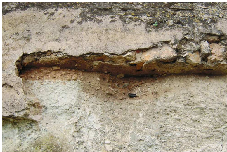
Fig. 9. Bolsada n° 1 entre la cimentación del fuerte y la roca madre
